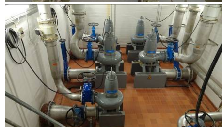
Fotos fra Mosede Rensningsanlæg.
